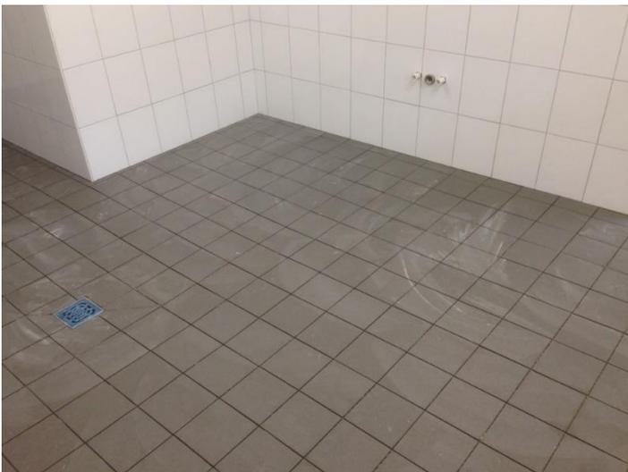
Nach einer weiteren Woche standen auch schon die Fliesenarbeiten an. Zuerst wurden die Wände mit einer Flüssigversiegelung und Dichtband versehen um eine wasserdichte Wanne herzustellen. Danach starteten die eigentlichen Fliesenarbeiten, diese dauerten bis zum 25. Juli 2016.
