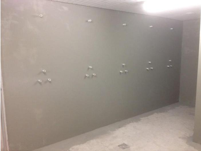
Die Wände wurden mit einem neuen Zementputz verputzt um wieder eine gerade Wand zu bekommen auf die die neuen Fliesen gelegt werden. Auch nach den Putzarbeiten wurde wieder mit Trocknungsgeräten gearbeitet um das über den Putz eingebrachte Wasser aus den Wänden zu bekommen und schneller weiterarbeiten zu können.
